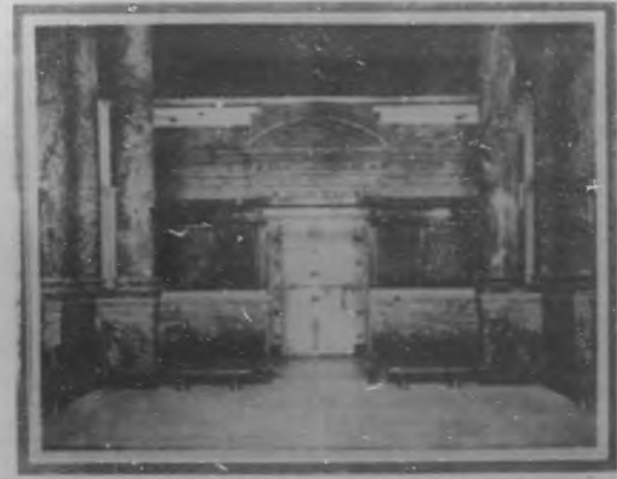
BANCO DE LA HABANA.—Entrada a la bóveda, de construcción modernísima y artística.
